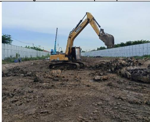
รูปที่ 2-3 การขุดดินเพื่อทำเสาเข็ม และการกองดิน
