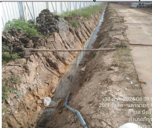
รูปที่ 2-3 การขุดดินเพื่อทำเสาเข็ม และการกองดิน
