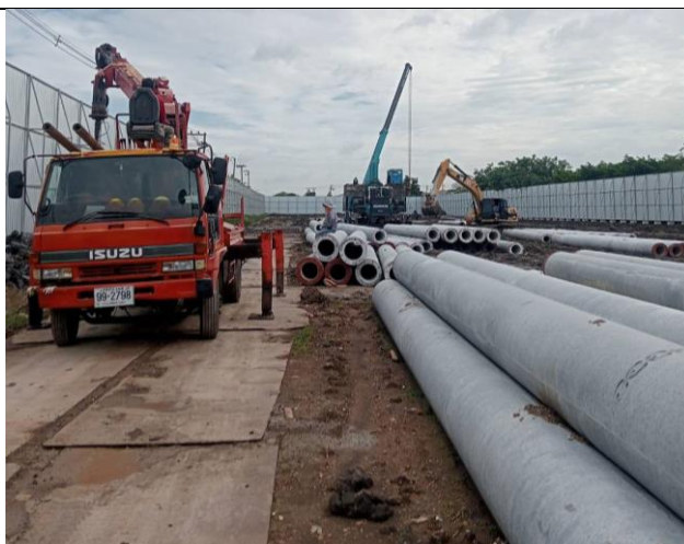
รูปที่ 2-19 การกองเก็บเสาเข็ม ให้เป็นระเบียบ ไม่กีดขวางพื้นที่ก่อสร้าง
