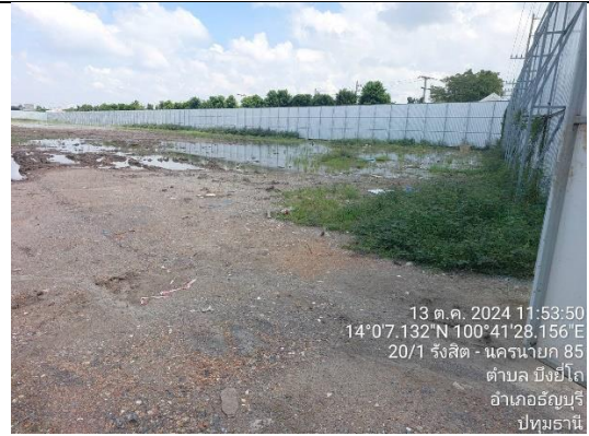
รูปที่ 2-1 การติดตั้งรั้ว Metal Sheet ขั้วคราวโดยรอบแนวเขตที่ดิน
