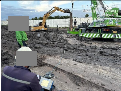
รูปที่ 2-2 การควบคุมการขุดดินและการทำเสาเข็ม ภายใต้การควบคุมของวิศวกรคุมงาน
