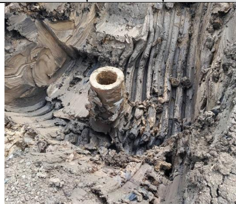
รูปที่ 2-3 การขุดดินเพื่อทำเสาเข็ม และการกองดิน
