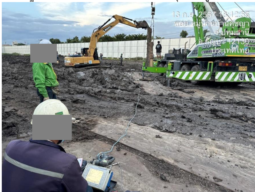
รูปที่ 3-2 การติดตั้งเสาเข็มของโครงการ
