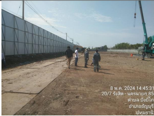
รูปที่ 2-1 การติดตั้งรั้ว Metal Sheet ขั้วคราวโดยรอบแนวเขตที่ดิน
