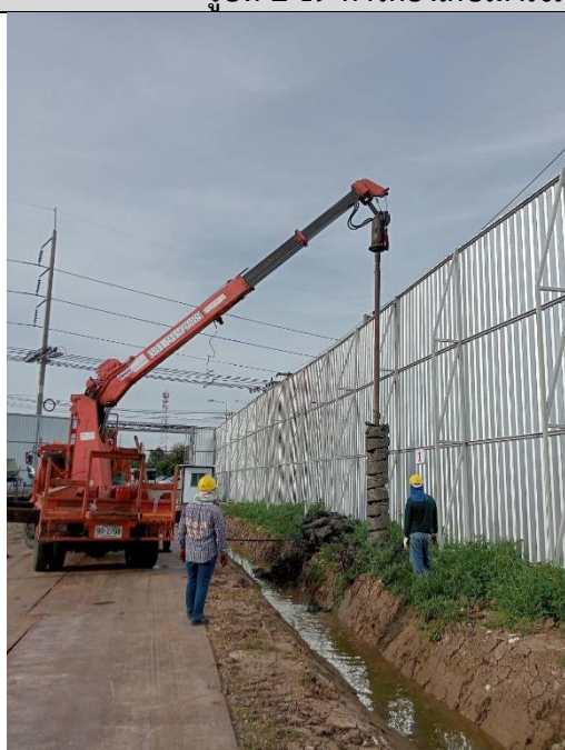
รูปที่ 2-20 รัศมีการทำงานของเครน ไม่ล้ำออกนอกพื้นที่โครงการ
