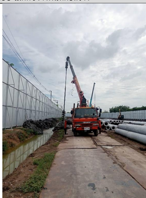
รูปที่ 2-20 รัศมีการทำงานของเครน ไม่ล้ำออกนอกพื้นที่โครงการ
