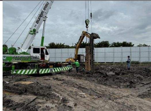
รูปที่ 2-2 การควบคุมการขุดดินและการทำเสาเข็ม ภายใต้การควบคุมของวิศวกรคุมงาน
