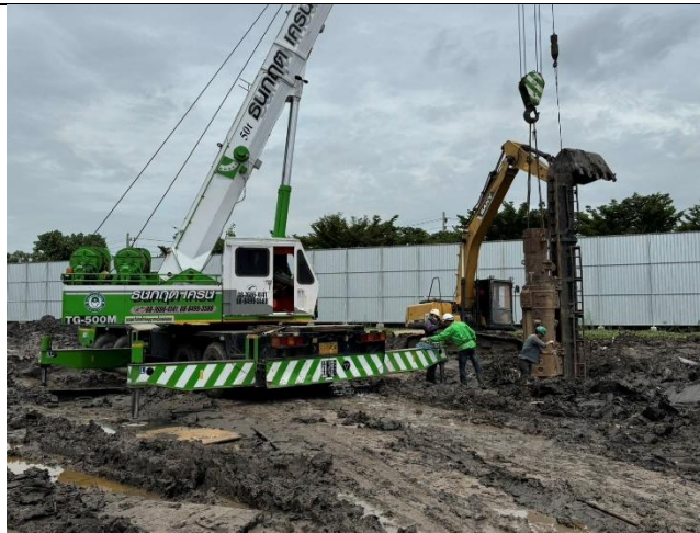
รูปที่ 2-8 เครื่องจักรกลที่ใช้ในการทำเสาเข็มที่ตรวจสอบให้อยู่ในสภาพดี
